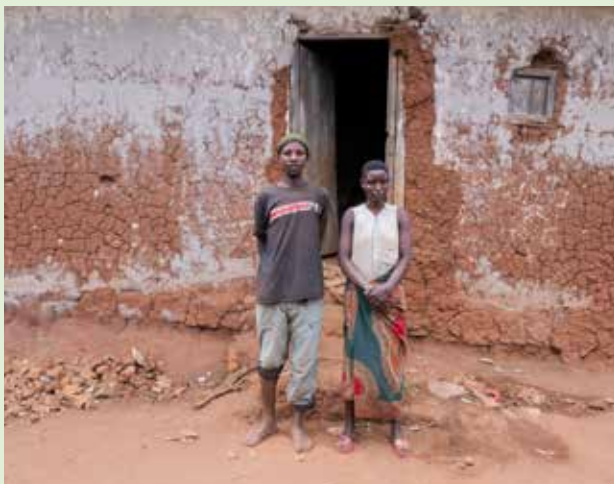
Theoneste e Nadine davanti alla loro casa nel 2023, quando l'abitazione era in condizioni fatiscenti e priva di una cucina e di un bagno adeguati.
